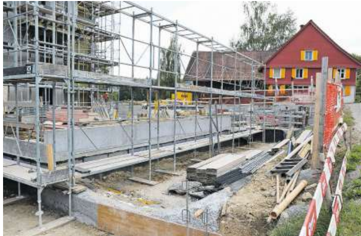
Derzeit noch eine Baustelle, entstehen hier an der Schwalbenstrasse in Vogelsang ab Frühling 2018 Teigwaren. Bild: Hans Suter
